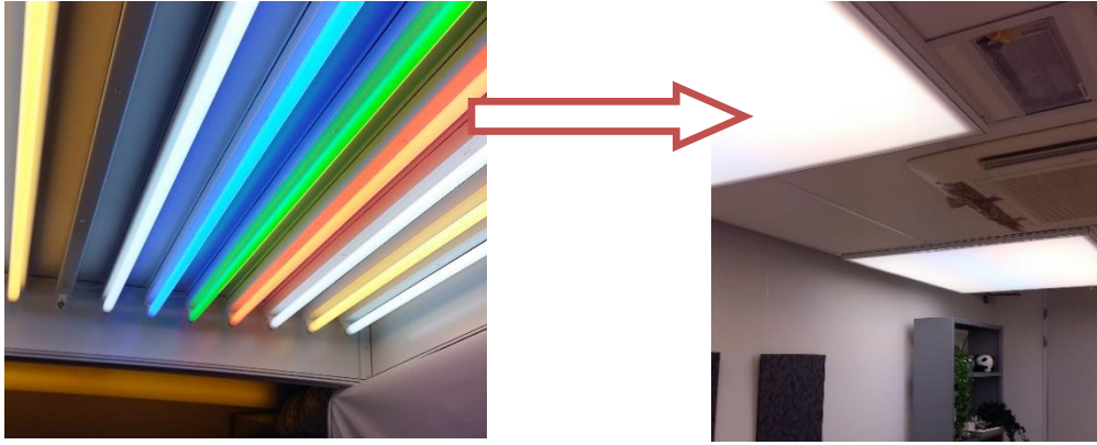
Obr. 3: Fototerapeutické svítidlo v univerzitní laboratoři, Groningen, Nizozemí. Různobarevné světelné zdroje jsou seskupeny do jednoho svítidla (vlevo), po překrytí difuzérem vytváří bílé světlo s plnospektrální charakteristikou (vpravo). Foto archiv autorů.
